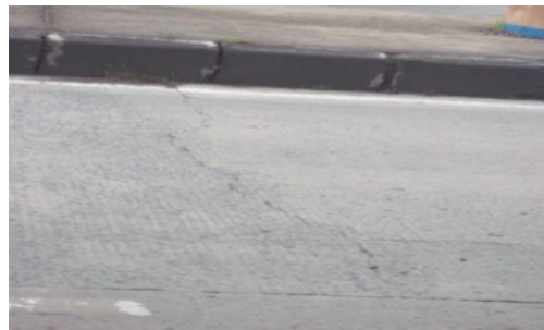
Gambar 4. Retak
